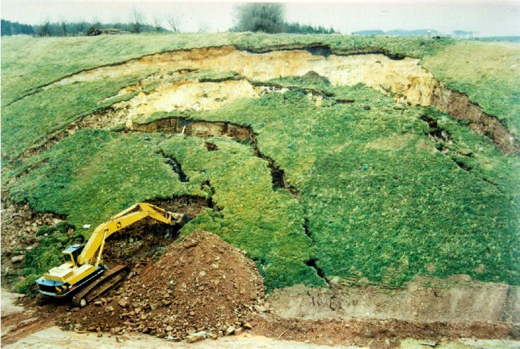
**Bild 5.17:** Beispiel eines Böschungsbruchs
